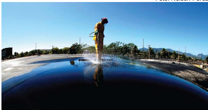
Trabalhador cuida dos geotubes- sacos geotêxteis que impedem que material dragado entre em contato com o ambiente no canal do Fundão. A mesma tecnologia será usada na Ilha da Pombeba.
