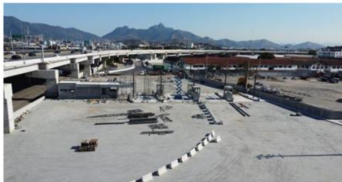
Vista geral da obra
