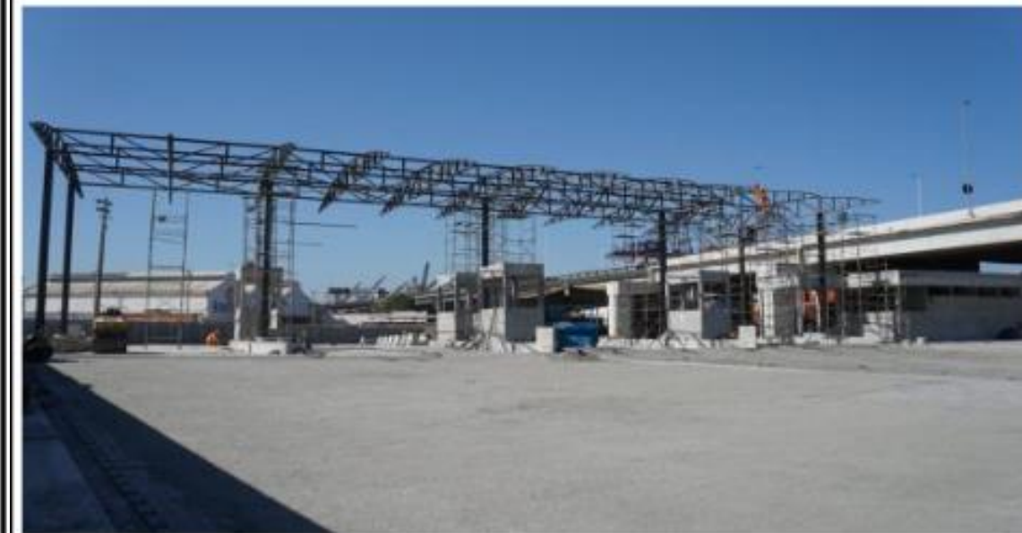
Vista geral: Estrutura metálica e piso intertravado
