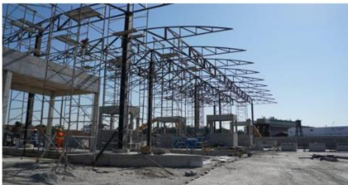
Montagem da estrutura metálica
