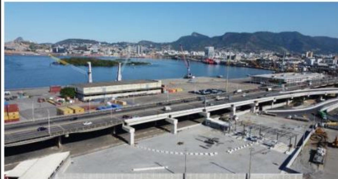
Vista geral da obra
