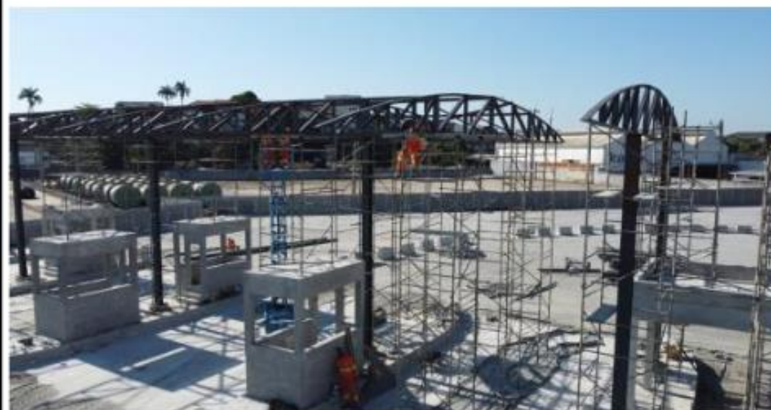
Montagem da estrutura metálica
