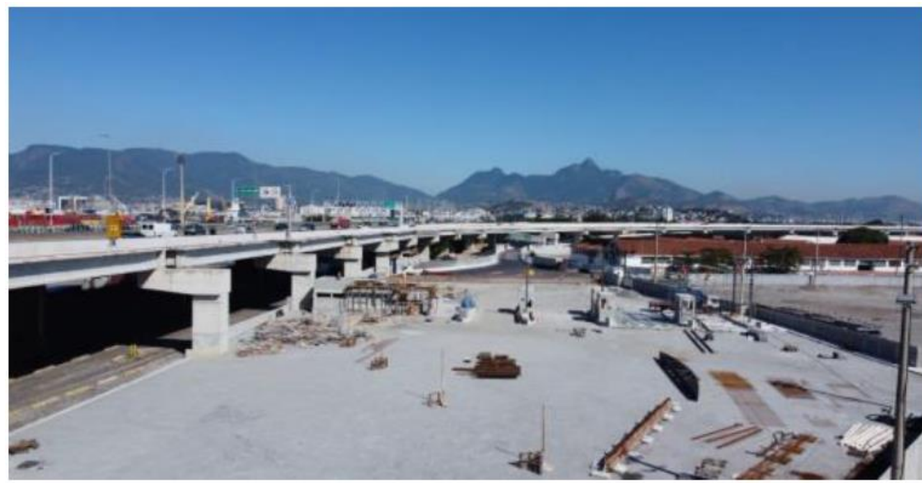
Vista aérea da obra
