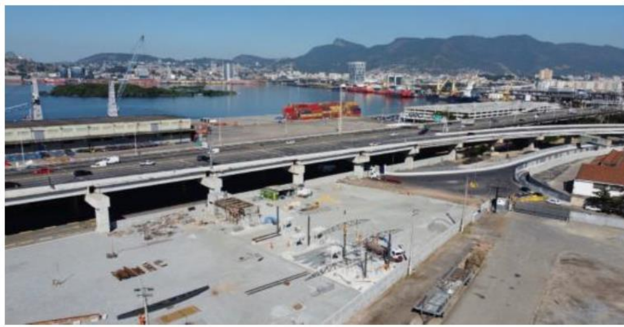
Vista aérea da obra
