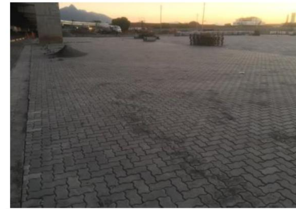
Revestimento de piso intertravado novo
