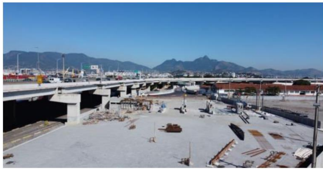
Vista aérea da obra
