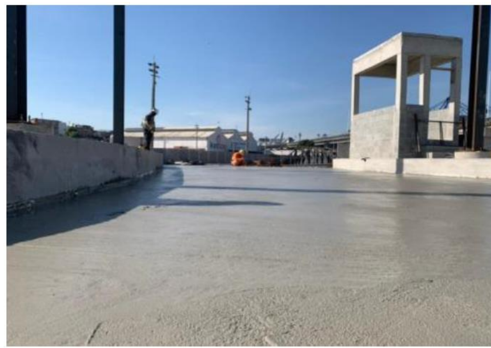
Execução de pavimento rígido com concreto fctmk > 4,5 Mpa
