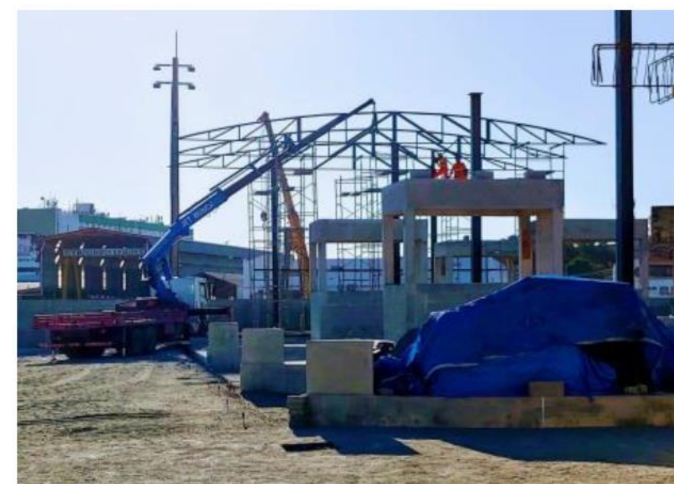
Montagem da estrutura metálica
