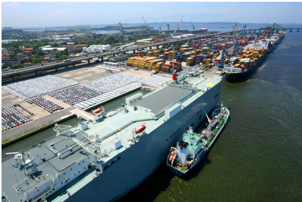
Foto 03 – Vista Aérea do Terminal da Multicar Rio
